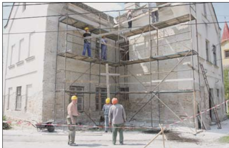
A Bagolyvárnál az állványzat felállítása zajlik a régi vakolat eltávolításához
