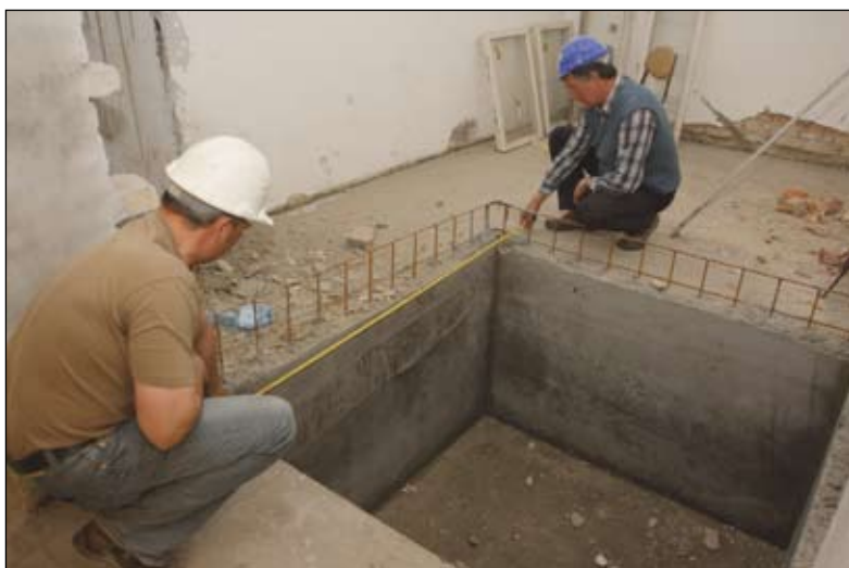
A Gárdonyi-iskolában az igazgatóhelyettesi iroda helyén lift épül. A liftakna süllyesztését mérik
